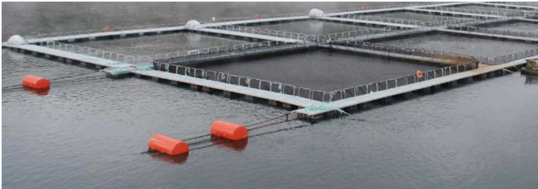
**c.- Cambiar cadena de 24mm negra grado U2 en la línea de fondeo, que esta en la conexión cáncamo de fondeo de la jaula y línea de fondeo, por cadena de 22mm galvanizada de alta resistencia. Con ello disminuimos el peso en los pasillos y aumentamos la resistencia de rotura del elemento.**
